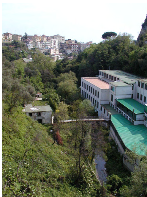
Figura 1.8 - Edifici (fabbrica di ceramica Solimena, ex Notari) costruiti nell'alveo del Torrente Bonea presso marina di Vietri (Foto Violante ).
