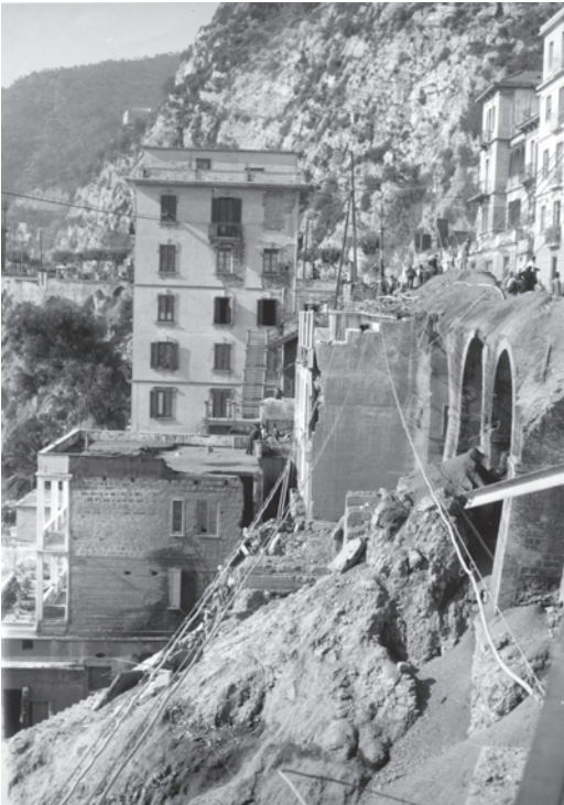
Figura 1.2 - Salerno, Rione Olivieri, crollo di abitazioni lungo la Strada Statale 18 Vietri sul Mare - Salerno (Foto Parisio 1954, Archivio EPT, Salerno).
