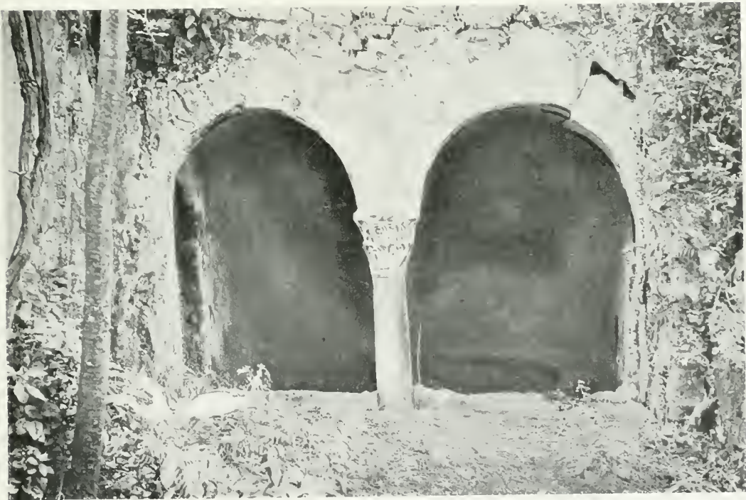
SORRENTO — INGRESSO DELLE « PISCINAE » ROMANE.
